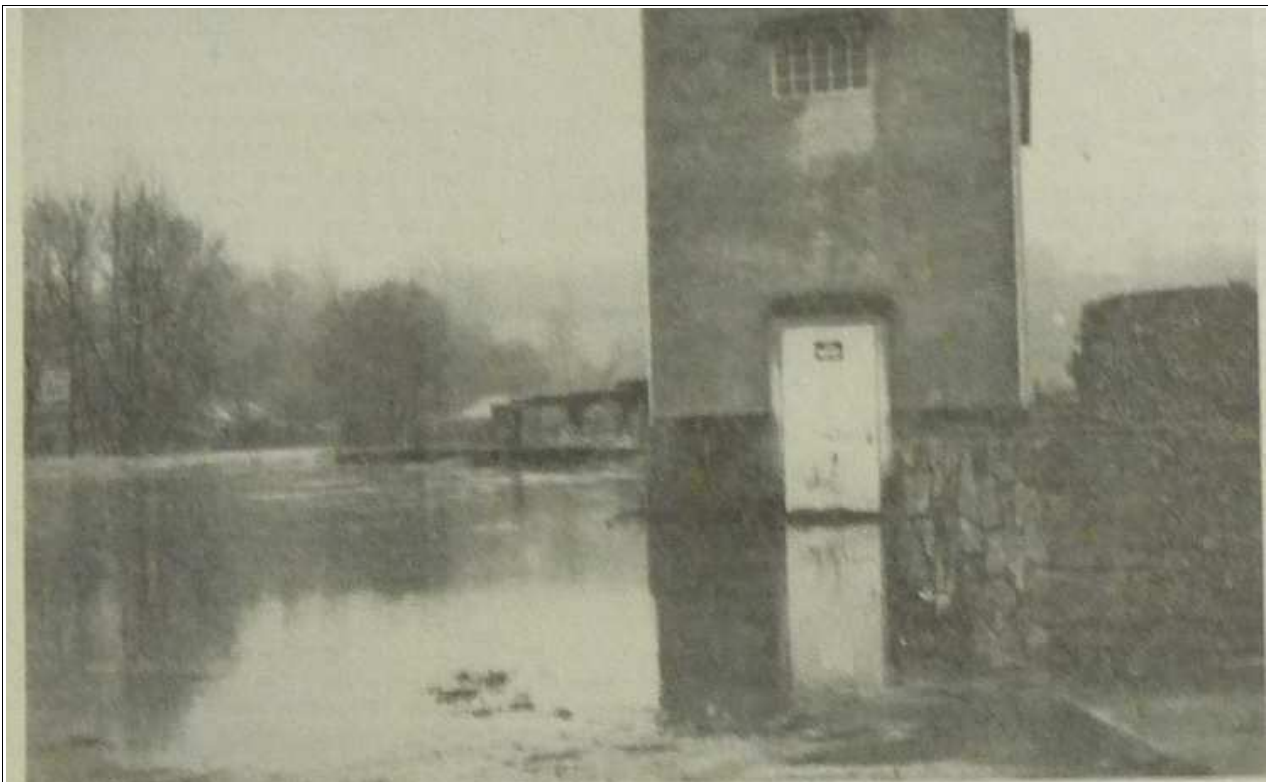
Situation dramatique hier pour les riverains de l'Hyères. La rivière a débordé, envahissant caves et jardins.
